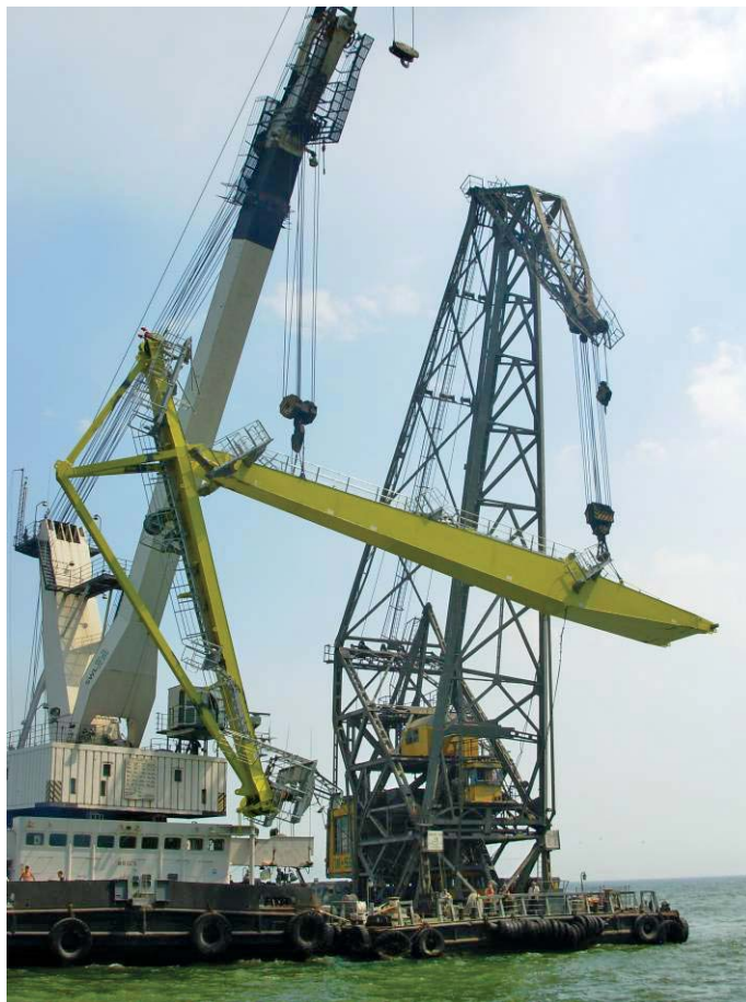
Монтаж порталного крана МАРК 40 в Мариупольском МТП
